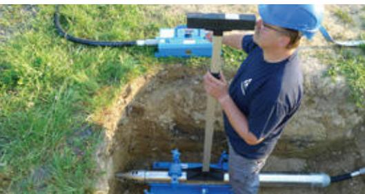
Für alle Bereiche der Versorgung, bei der das Bodenverdrängungs- oder Berstlining-Verfahren angewendet wird – z.B. bei Hausanschlussleitungen, Straßenquerungen, Bahndämmen, Gartenanlagen oder anderen erhaltenswerten Oberflächen – zeichnet sich das System Rocket Pipe in der Regel als wirtschaftlicher aus. Rocket Pipe Rohre werden vorzugsweise zum Schutz von Telekommunikationsleitungen, Energiekabeln sowie Gas- und Wasserleitungen eingesetzt.
