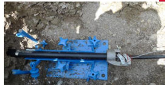
Mit dieser Verfahrenstechnik lassen sich ohne durchgehendes Aufgraben Verkehrswege kreuzen und Hausanschlüsse herstellen. Zuvor werden eine Start- und eine Zielgrube ausgehoben. In Einzelfällen kann auch direkt aus dem Kellerbereich gestartet werden. Das erspart eine Startgrube bzw. ein Kopfloch, und das Gelände bleibt unberührt.
